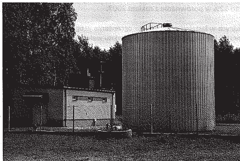
Rysunek 14. Stacja Uzdatniania Wody w Myszadłach
